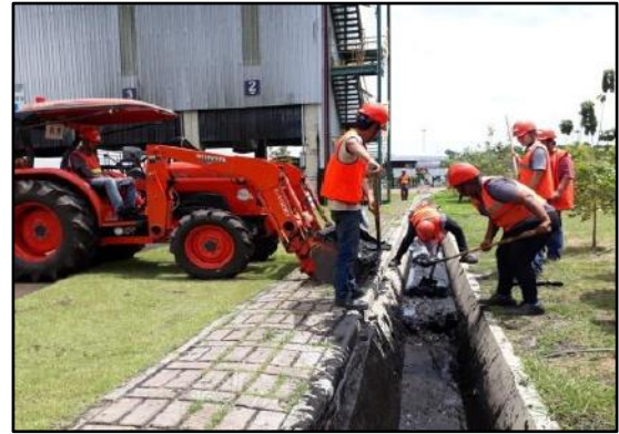
ภาพที่ 2.37 การขุดลอกระบบระบายน้ำภายในพื้นที่โครงการ
